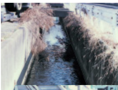
清掃前の水路 周辺の状況
