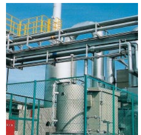
吉田南工場のコジェネ型発電機
