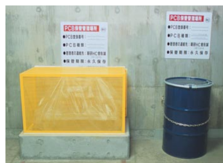
朝霞技術開発センターにおけるPCBの管理状況
